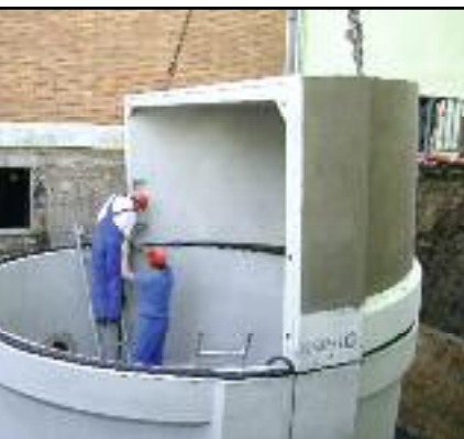
Schema Hackschnitzel-Großbehälter
