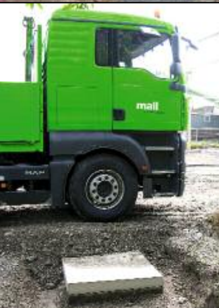
Hohe punktuelle Belastung (SLW 60) bei sehr oberflächennahem Einbau
