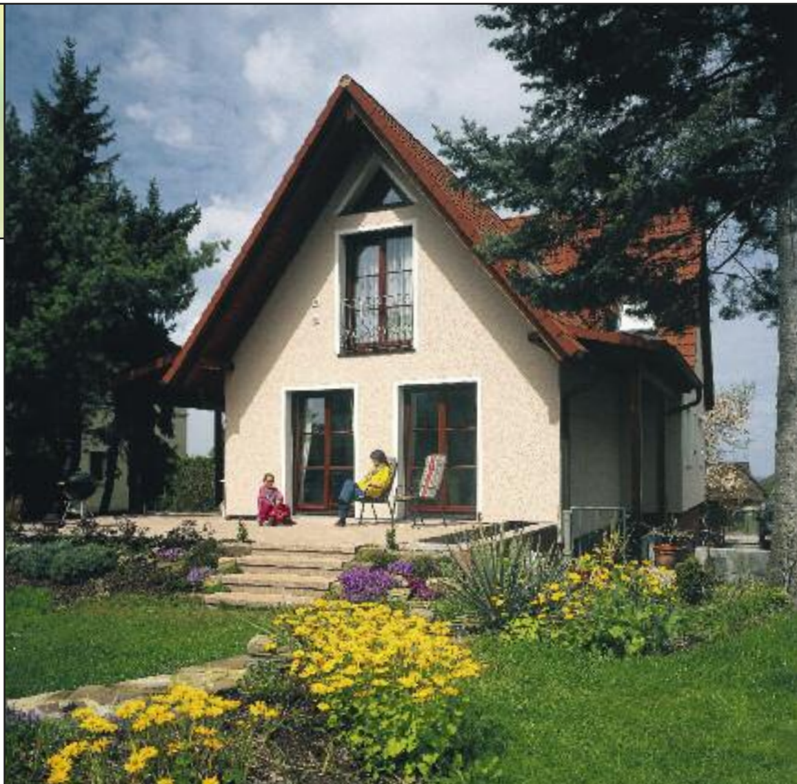
Die belüftete SBR-Kläranlage von Mall
