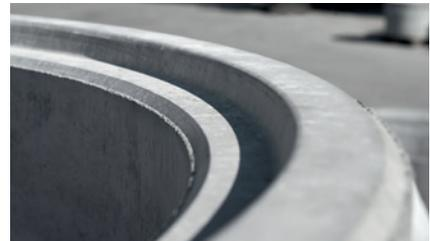
Bauteilverbindung mit Falz und bauseitiger Mörtelfuge
