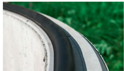
Bauteilverbindung mit verschraubter Elastomer-Dichtung
