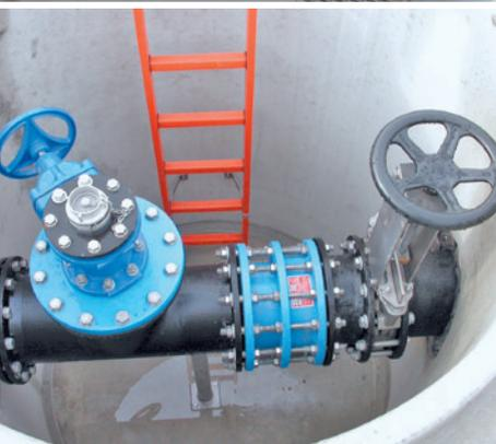
Wenn Druckleitungen mit Armaturen versehen werden, sind Mall-Armaturenschächte die richtige Wahl. Montagefertig angeliefert, ist ein schneller Einbau und eine hohe Qualität durch die Werksmontage möglich. In enger Zusammenarbeit mit dem Planer verwendet Mall für Rohrleitungsmaterialien und Armaturenausrüstungen ausschließlich hochwertige, korrosionsfreie Werkstoffe.
