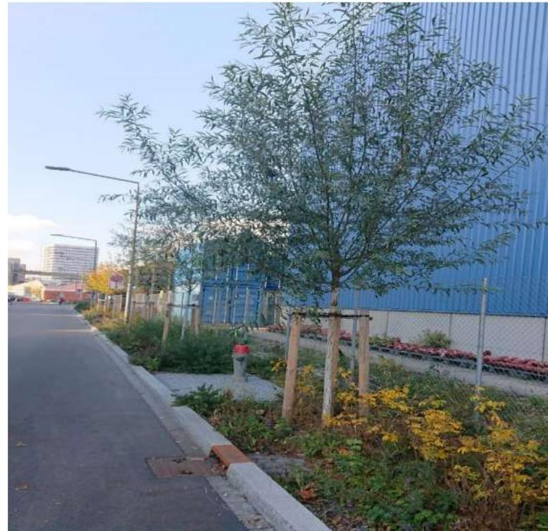
Der Klimadeckel leitet im Sommer das Regenwasser von der Strasse in die Baumrigole (Versickerung). Im Winter wird das salzverschmutzte Wasser abgeleitet.
